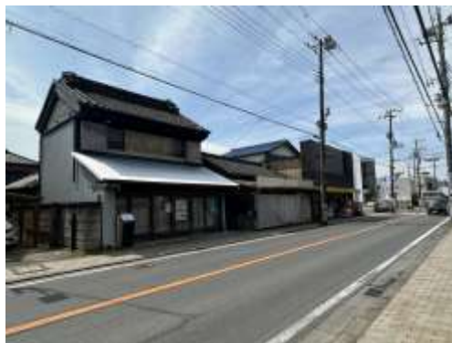
写真 6-4 現在の旧道沿いの景観
