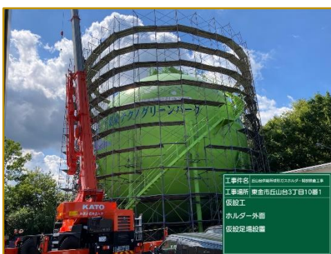
丘山台ガスホルダー開放検査の準備段階の様子
