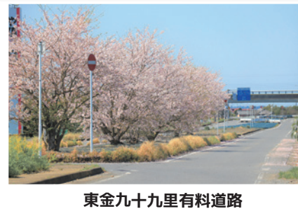
東金九十九里有料道路 押堀インターチェンジ付近
