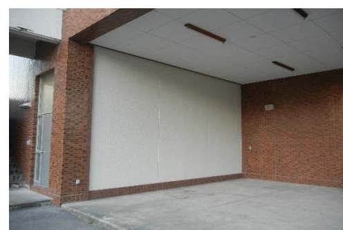
鉄筋コンクリート増設壁
