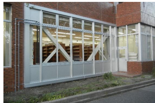
鉄骨枠付 K 型ブレース
