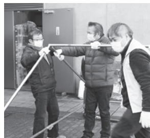
まずはボランティアセンターを設営しました
