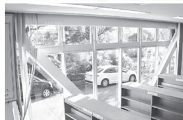
斜めの鋼材や耐震壁を設置し、耐震性を強化しました
