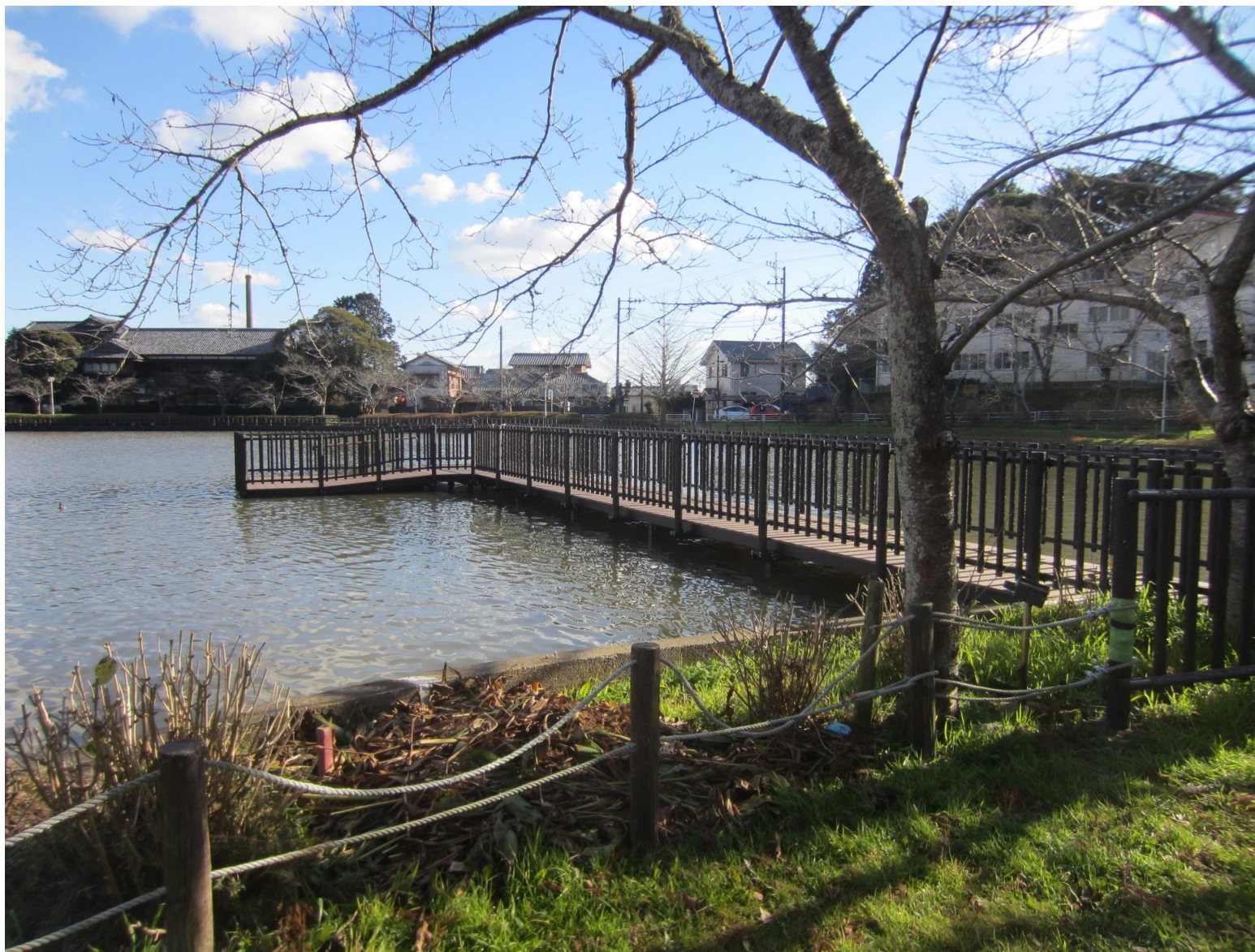
(補足説明資料) ハス観賞用の栈橋
