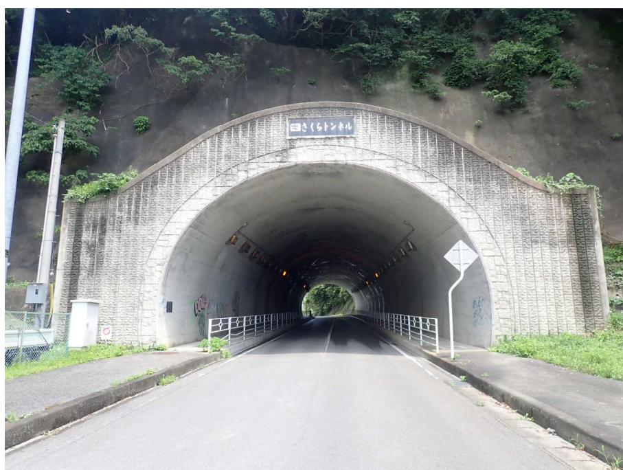
市道 0106 号線 さくらトンネル
