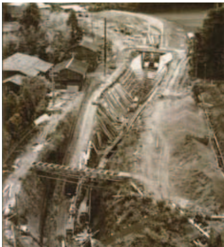
南部幹線の掘削工事
