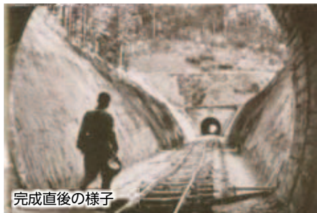
トンネル工事
