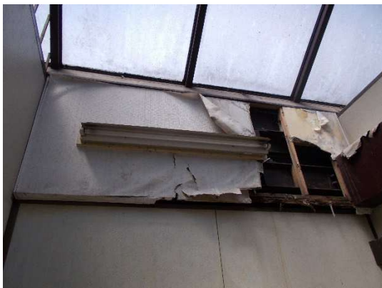
屋根からの雨漏りの影響により、トイレの壁が破損しております
