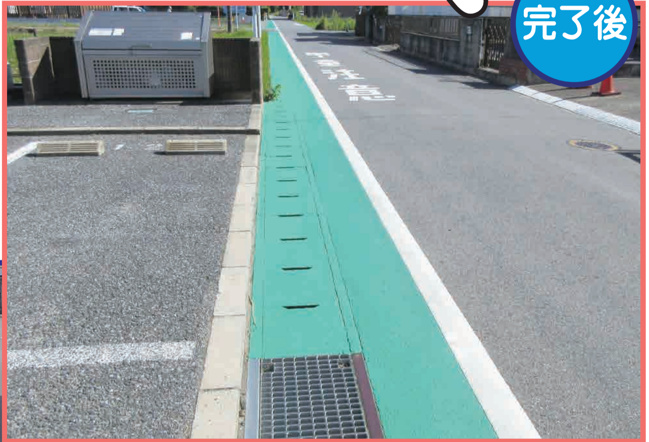
令和4年第2回(5月)臨時会において議決された「交通安全施設整備事業」として、市内小学校周辺の通学路の安全性を向上させるため、グリーンベルトの整備などが行われました。
