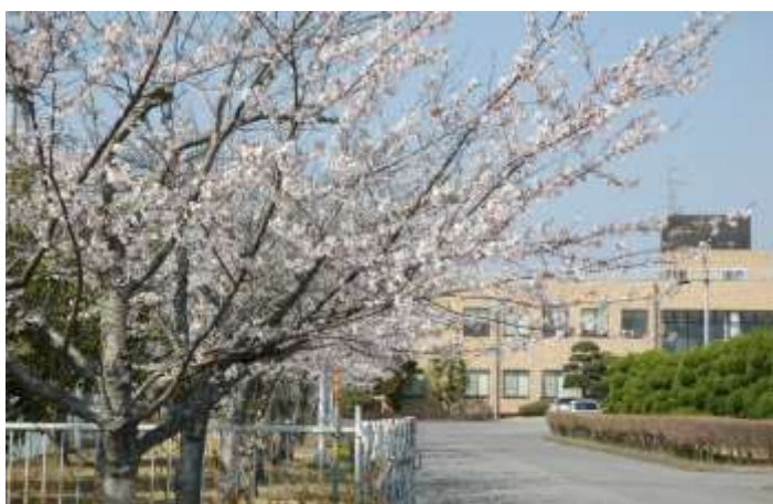
東金市浄化センター
