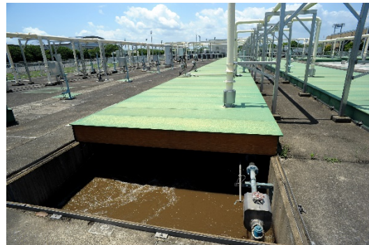
東金市浄化センター（反応タンク）
