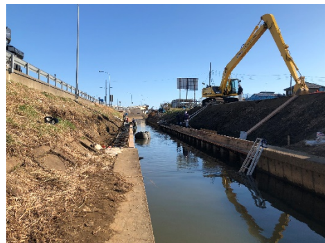
北幸谷川の改修
