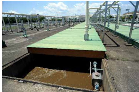
東金市浄化センター（反応タンク）
