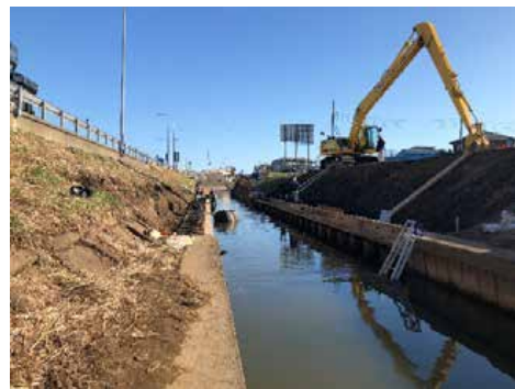
北幸谷川の改修
