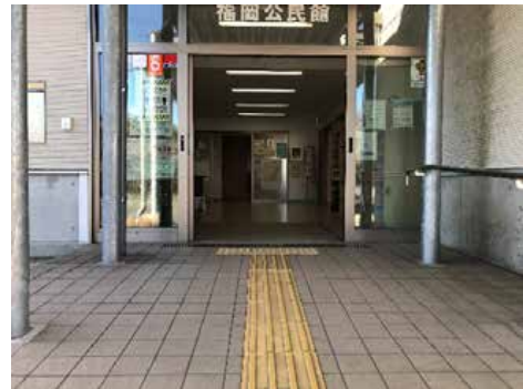
バリアフリー化・点字ブロック(福岡公民館)
