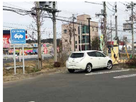
電気自動車と充電スタンド（道の駅 みのりの郷東金）
