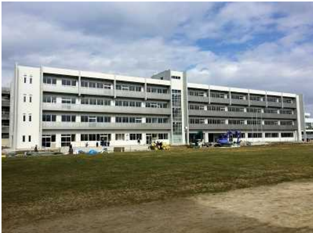
平成27年度に完成した東金中学校新校舎
