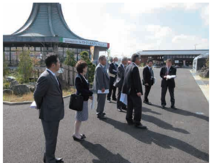
産業交流拠点施設(みのりの郷東金) 圃場等舗装工事
