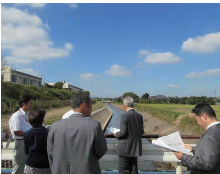
北幸谷川護岸補修工事
