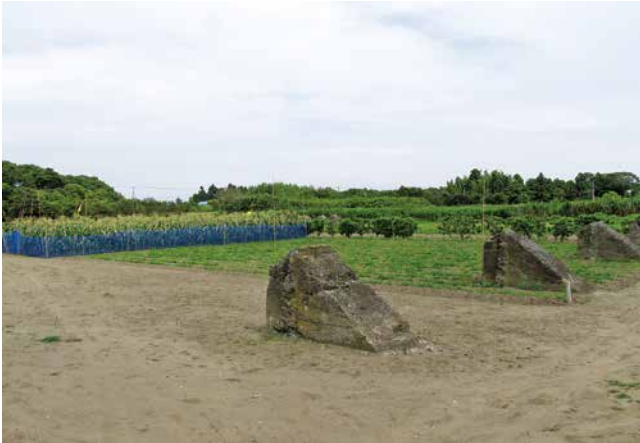
現存する格納庫(豊成)の基礎部
