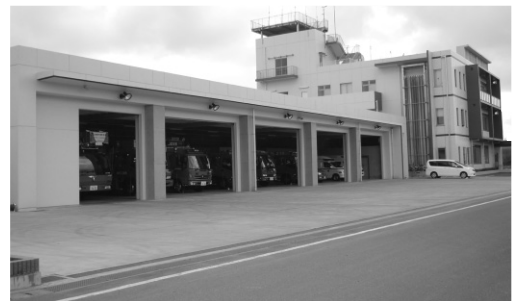
平成 24 年 3 月に家徳地先へ移転した中央消防署
