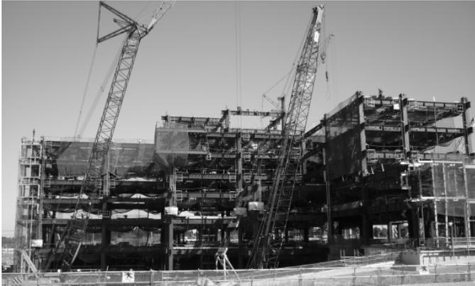
高層部まで鉄骨が組み上げられた建設中の東千葉メディカルセンター
