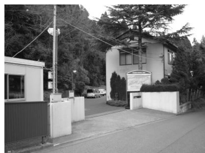
今後の利活用が検討される国営両総農業水利事務所
