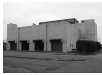
改築更新工事を進めている浄化センター施設
