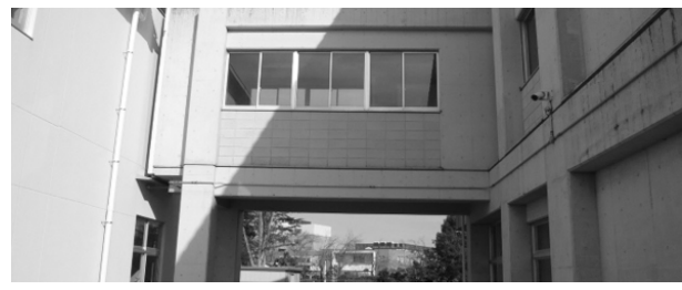
補正予算により2階渡り廊下の接続工事を行なう正気小学校
