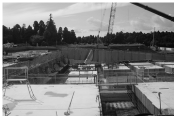
基礎工事が進む東千葉メディカルセンター
