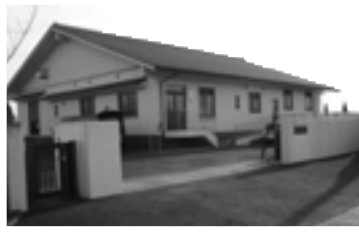
嶺南・正気西部クリーンセンター
