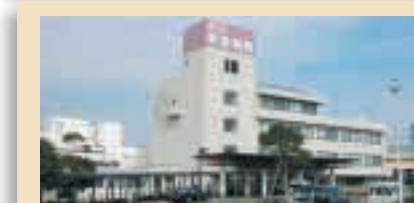
11 県立東金病院 Chiba Prefectural Togane Hospital 地域医療の中核を担う総合病院です。 台方1229 TEL 0475-54-1531
