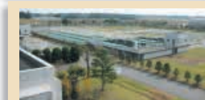
13 浄化センター Sewage Treatment Center 市の各地区から排水される年間約14,000m 3 もの汚水を浄化処理しています。 家徳256-1 TEL 0475-52-0203
