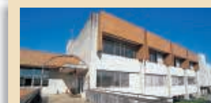
7 中央公民館 Central Public Hall 講堂、会議室、調理室、和室などがあり、生涯学習活動の中心拠点です。 東岩崎1-20 TEL 0475-50-1191
