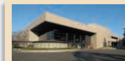
4 東金文化会館 Togane Bunka Kaikan 大小ホールや子ども科学館、会議室などがあります。 八坂台1-2107-3 TEL 0475-55-6211
