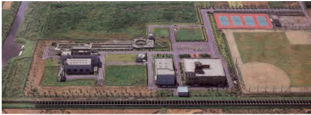
浄化センターが完成(1985) Completion of the water treatment center
