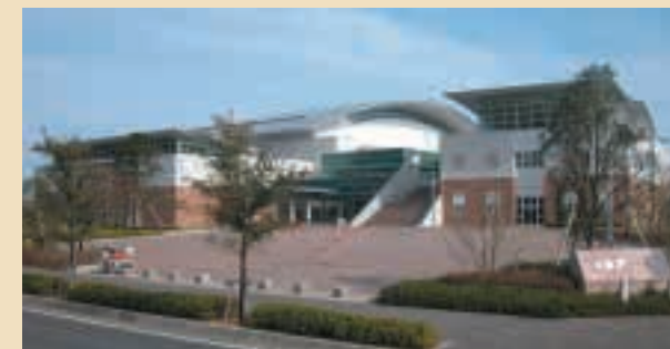
②東金アリーナ Togane Arena Facilities 体育館、陸上競技場、トレーニングルームなどがあります。 堀上1361-1 TEL 0475-50-1715
