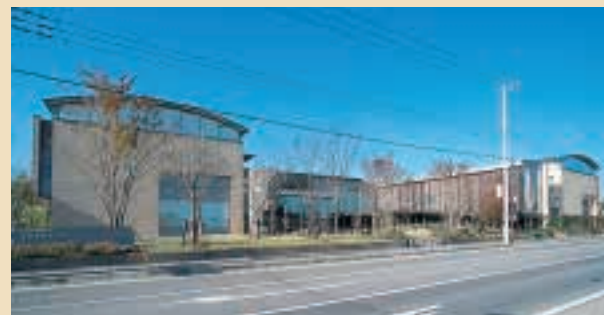
①ふれあいセンター(保健福祉センター) Fureai Center (Health and Welfare Center) 健診室や福祉相談窓口、ボランティアルームなどがあり、さまざまな保健福祉サービスを提供しています。 田間421 TEL 0475-50-1230
