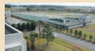
⑬浄化センター Sewage Treatment Center 市の各地区から排水される年間約14,000m 3 もの汚水を浄化処理しています。 家徳256-1 TEL 0475-52-0203
