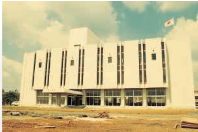
山武郡市振興センターが完成(1972) Completion of the Sambu City Promotion Center
