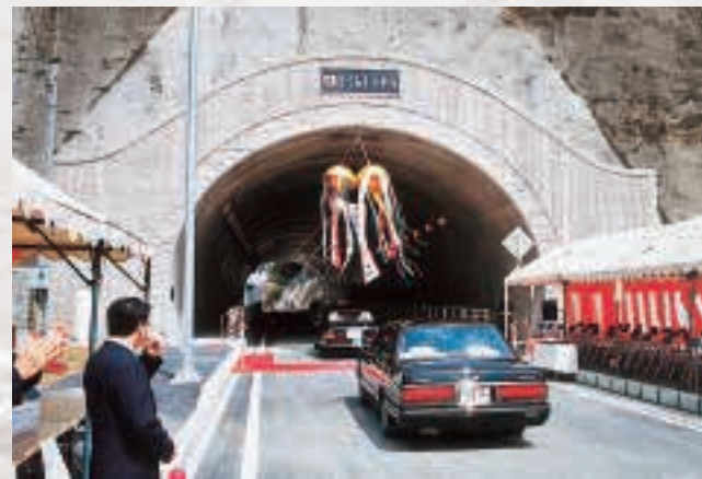
さくらトンネルが開通(1993) Opening of the Sakura Tunnel 台方地区と谷地区(八鶴湖方面)を結ぶ延長84m、幅員11mのトンネルが開通しました。自動車が対面通行できるようになり、両側に歩道もつけられました。トンネル名は市民から募集し名づけられました。
